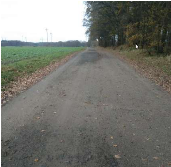
Abbildung 55: Breiter Wirtschaftsweg mit schweren Schäden
