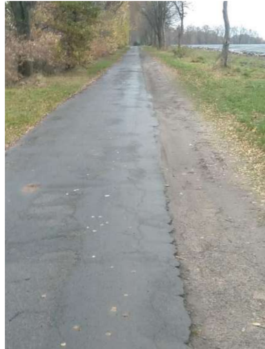
Abbildung 56: Weitgehend zerstörter Wirtschaftsweg, der den Belastungen offensichtlich nicht gewachsen ist
