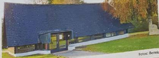
Sanierungsbedürftig: die Friedhofskapelle in Ohrensen.
