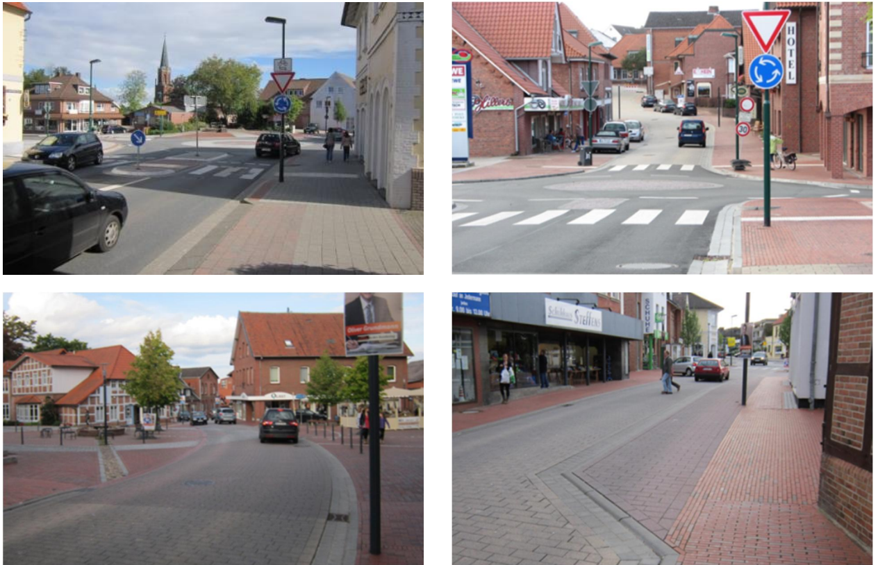
Abb. 10 Kreisverkehre im Westen (links oben) und Osten (rechts oben) der Marktstraße, platzartige Straßenraumgestaltung (links unten) und Fahrbahneinengung (rechts unten)
