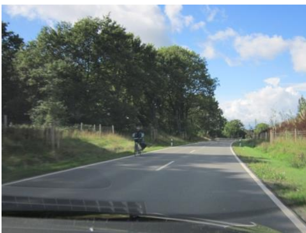
Befahrung Umgehungsstraße K 26n, Nutzung durch Radfahrer
