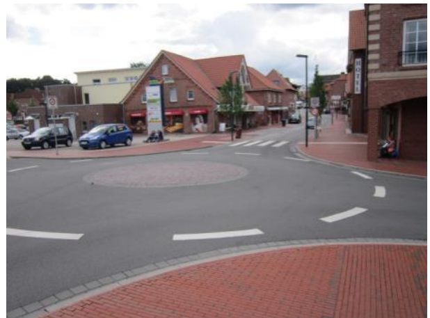
Minikreisverkehr Marktstraße/Buxtehuder Straße/Schulstraße
