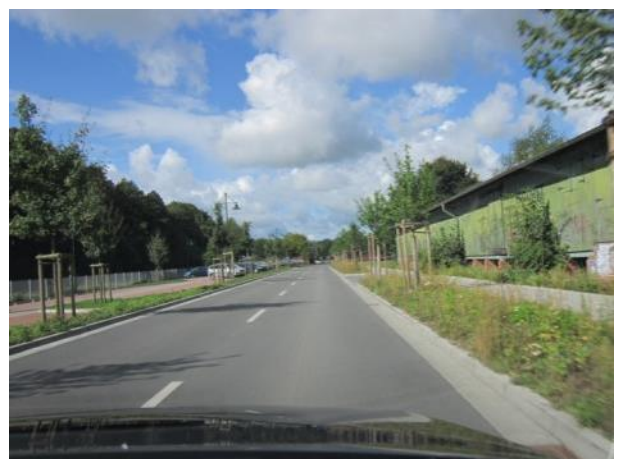
Befahrung Umgehungsstraße K 26n, westlicher Abschnitt (Bahnhof)
