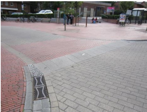
Gehwegaufpflasterung im Knotenpunkt Marktstraße/Mittelstraße
