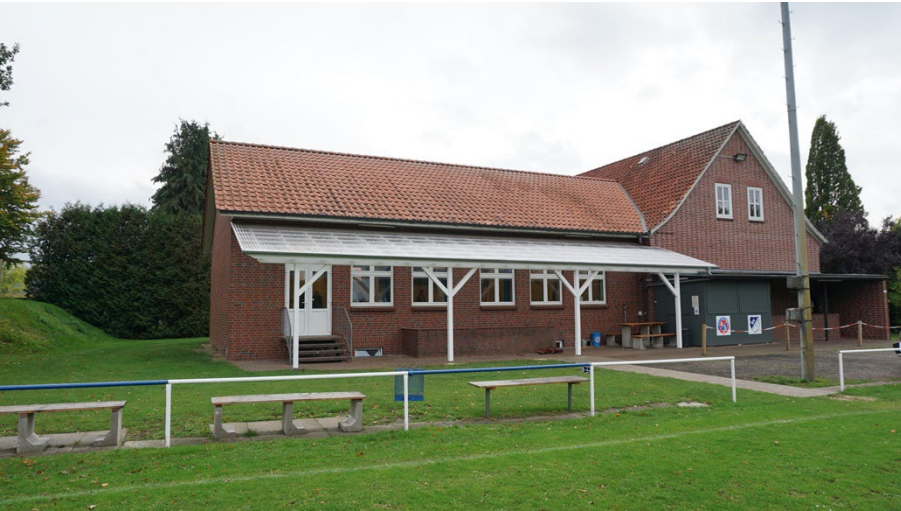
Abbildung 44: Bestandssituation DGH Ottendorf
