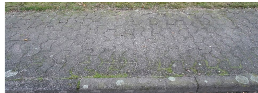
Abbildung 35: Bestandssituation Fußwege Oersdorf
