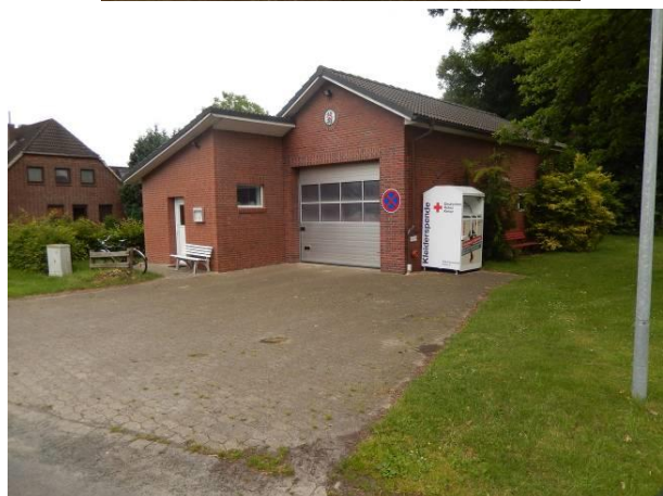
Feuerwehr Brest – Vorplatz-/Umfeldgestaltung verbesserungswürdig (Verlagerung in den Bereich des DGH wird angestrebt)
