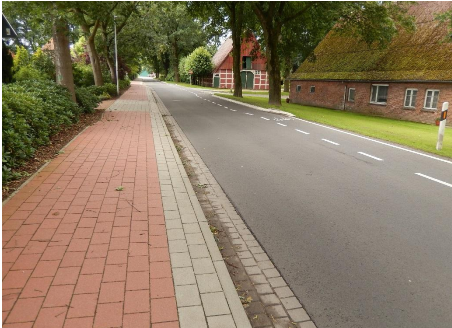
Ortsdurchfahrt Essel nach der Fertigstellung - Das Ortsbild hat sich positiv verändert.
