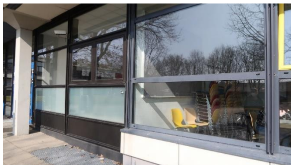
Abbildung 13: Rechts Anbau der Mensa (2008), links Gebäudeteil aus den 1970ern (Eigene Darstellung)
