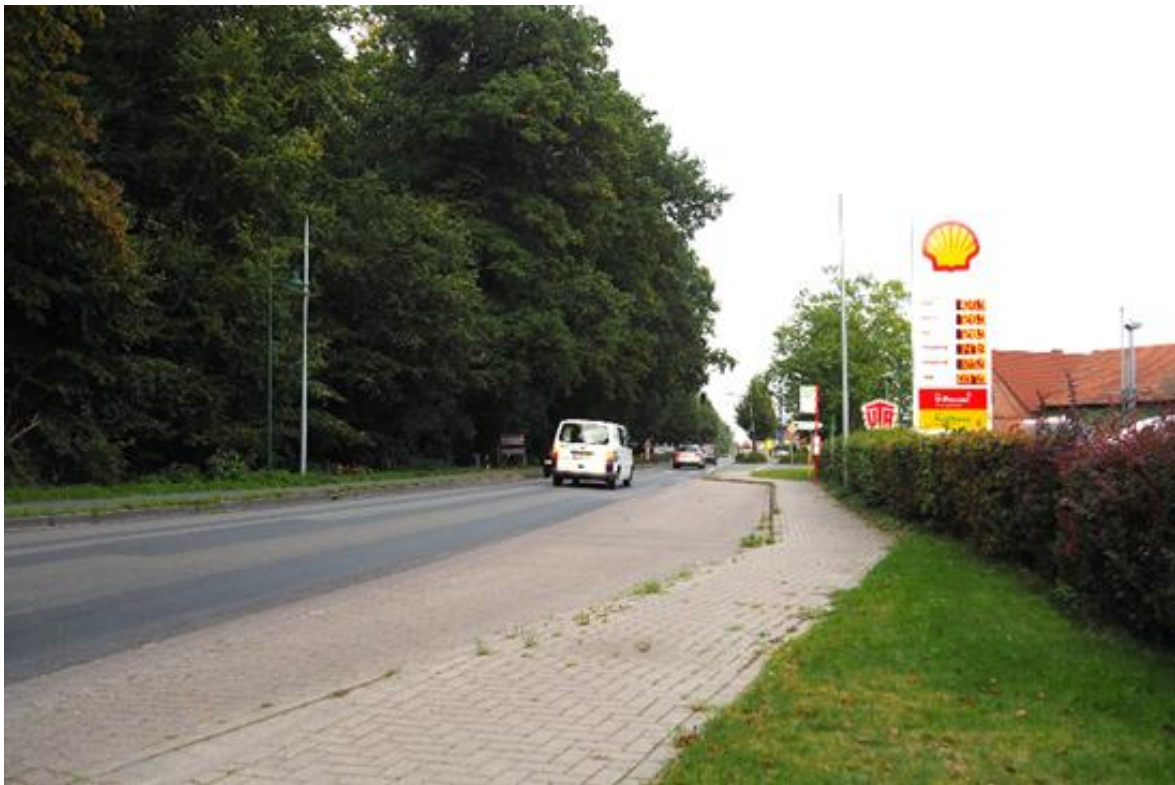
Abbildung 23: Ortseingang in der Friedrich-Huth-Straße
