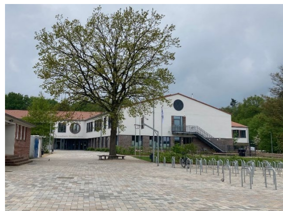
Abbildung 17: Neues Schulgelände und -gebäude
