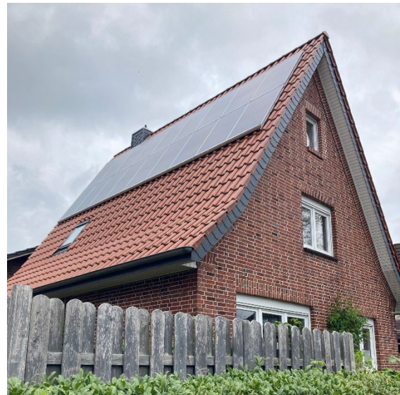
Abbildung 14: Gebäude nach Sanierung
